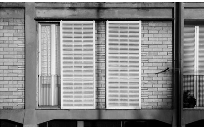
28 - L'edificio a pianta stellare: alcune varianti delle campate modulari delle facciate
