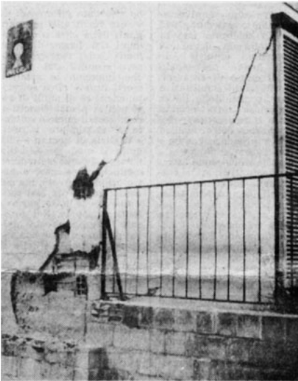
9 - Le lesioni su una delle schiere del nucleo sud orientale, 1962 [L'UNITÀ 1963]
