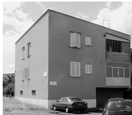
13 - Veduta d'epoca e veduta attuale di un elemento delle unità di buon vicinato. Tra le principali trasformazioni si notano: le alterazioni cromatiche con l'occultamento del telaio strutturale; la chiusura dei piani pilotis e delle logge; la modifica delle dimensioni delle bucaute con sostituzione dei serramenti e dei sistemi di oscuramento originali; la realizzazione di nuove finestre
