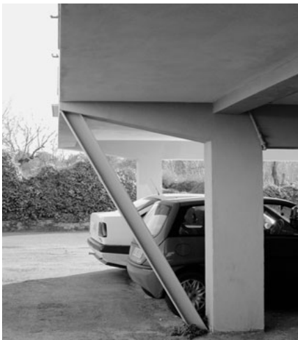
11 - Intervento di consolidamento di una trave a sbalzo effettuato con l'uso di un puntello di acciaio
