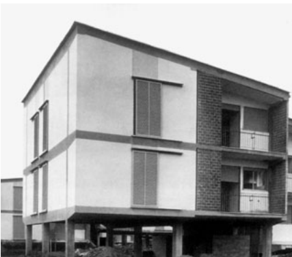
13 - Veduta d'epoca e veduta attuale di un elemento delle unità di buon vicinato. Tra le principali trasformazioni si notano: le alterazioni cromatiche con l'occultamento del telaio strutturale; la chiusura dei piani pilotis e delle logge; la modifica delle dimensioni delle bucaute con sostituzione dei serramenti e dei sistemi di oscuramento originali; la realizzazione di nuove finestre
