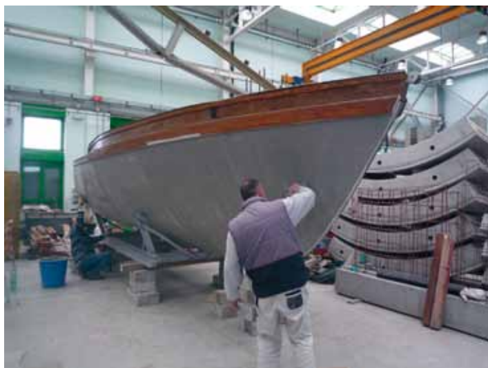
Fig. 5 - La motobarca di ferroceemento “La Giuseppa” durante il restauro nel Laboratorio di materiali e strutture del Dipartimento di Ingegneria Civile di Roma Tor Vergata, 2011 (foto autori)
