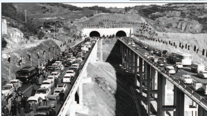
8. L'inaugurazione della Transappenninica presso la galleria Citerna, il 3 Dicembre 1960 (archivio fotografico Autostrade per l'Italia - Collezione SIXXI)
