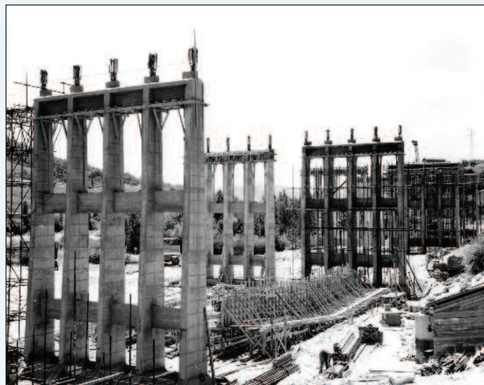
5. Il viadotto Quercia Setta tra Bologna e Firenze sulla Autostrada del Sole: Riccardo Morandi con l'Impresa Sogene, cantiere del 1959 (ACS, archivio fotografico Sogene - Collezione SIXXI)
