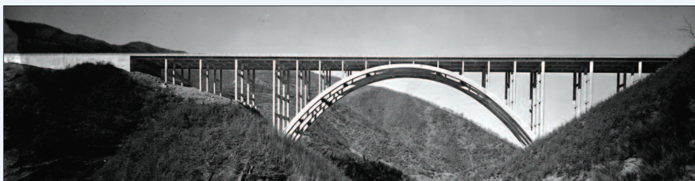
3. Il viadotto Gambellato tra Bologna e Firenze sulla Autostrada del Sole: Giulio Krall con l'Impresa Ferrobeton, cantiere del 1959 (archivio Fotografia Giacomelli - Collezione SIXXI)
