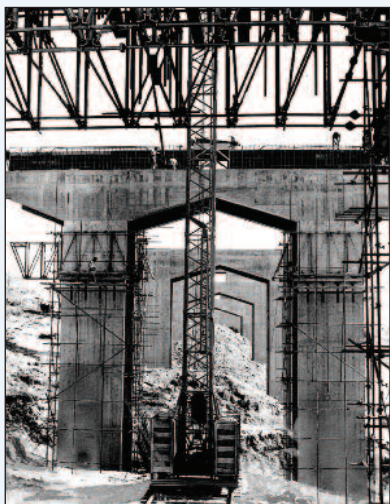
6. Il viadotto Bellosguardo tra Bologna e Firenze sulla Autostrada del Sole: Silvano Zorzi con l'Impresa Astaldi, cantiere del 1959 (archivio Autostrade per l'Italia - Collezione SIXXI)
