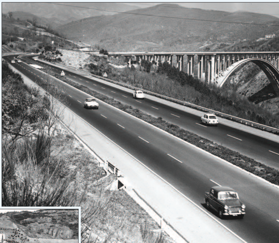
7. Il viadotto sul torrente Aglio tra Bologna e Firenze sulla Autostrada del Sole: Guido Oberti con l'Impresa Romagnoli, cantiere del 1960 (archivio fotografico Autostrade per l'Italia - Collezione SIXXI)
