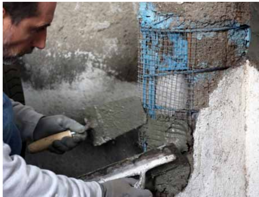
20 Reproduction du ferrociment, 2013: un fragment de la paroi verticale courbe du Pavillon de la Magliana.
