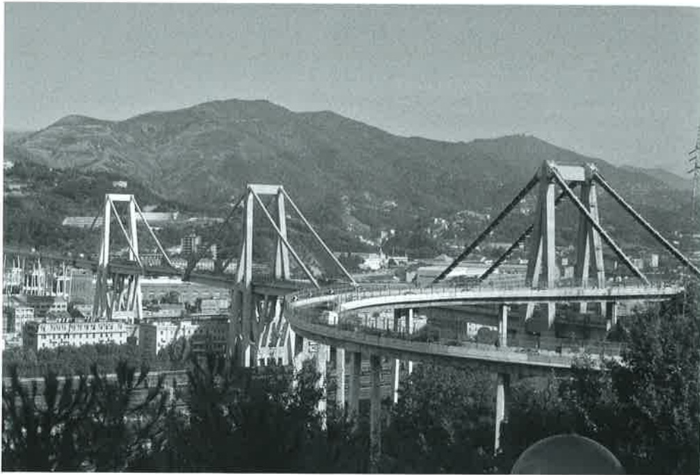
Figure 9. Polcevera Bridge, Genova. R. Morandi, 1960-67. Photo: Sergio Poretti.
