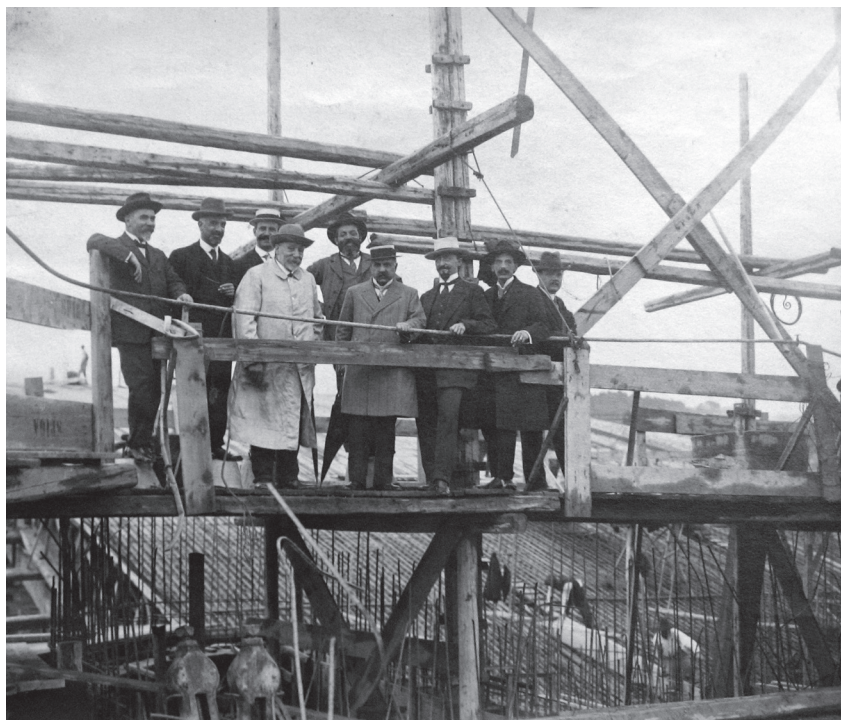
Fig. 5 - Tutti in cantiere il giorno del primo getto di calcestruzzo, il 7 ottobre 1910: si riconoscono da sinistra a destra, G.A. Porcheddu, E. Giay, S. Chiera, F. Hennebique con l'impermeabile bianco, G. Gatta Castello, R. Bentivegna, C. Parvopassu, C. Di Fenizio e L. Somma (ASBAH)
