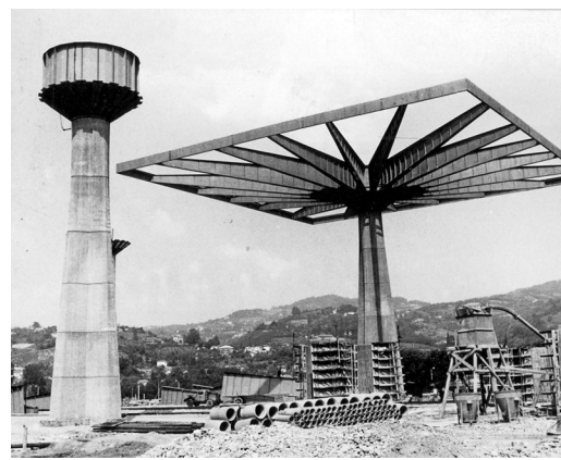
Fig. 6. Pier Luigi Nervi, palais du travail à Turin (1959-61), vue du chantier.
