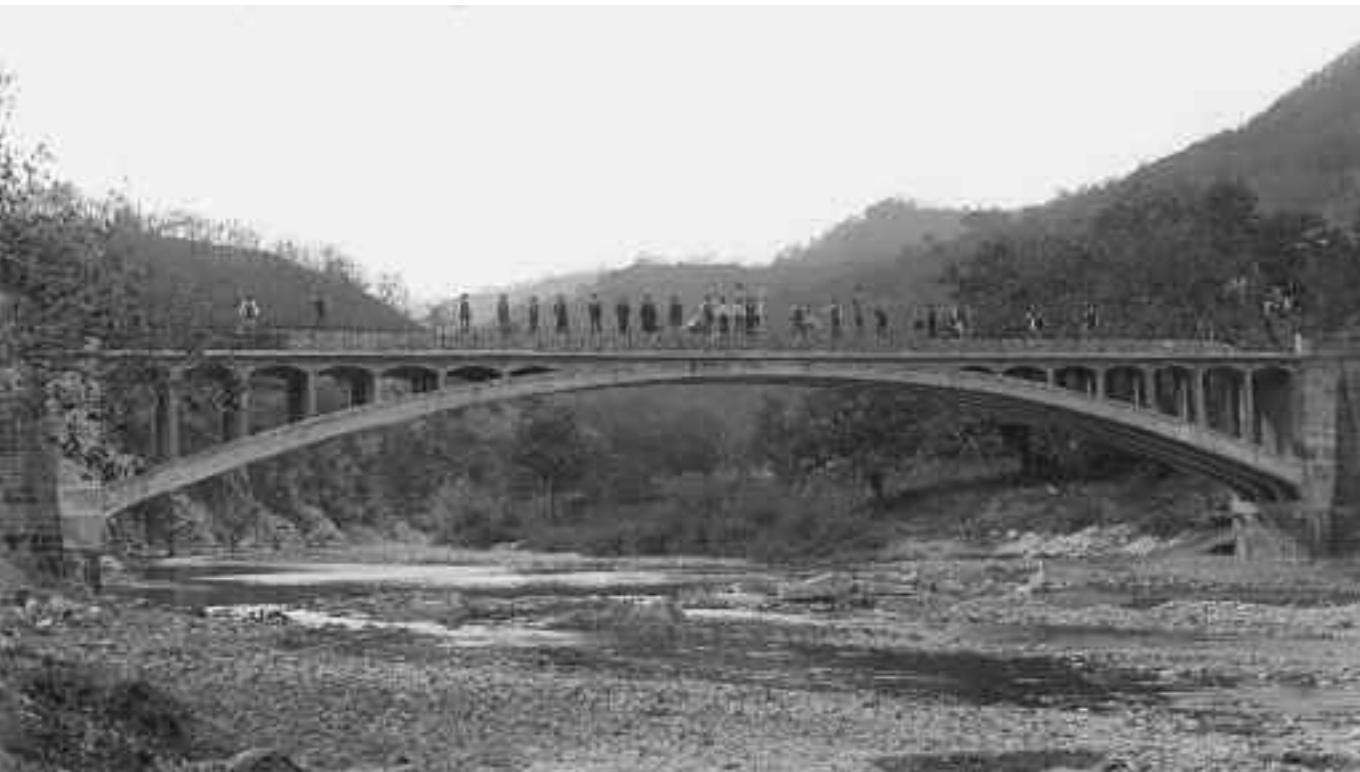
PONTE IN CEMENTO ARMATO SULLA BORMIDA A MILLESIMO
