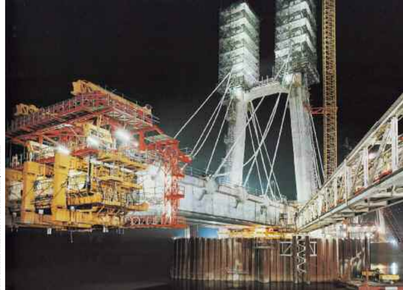
PONTE FERROVIARIO STRALLATO SUL PO PER L'ALTA VELOCITÀ, M. PETRANGELI
