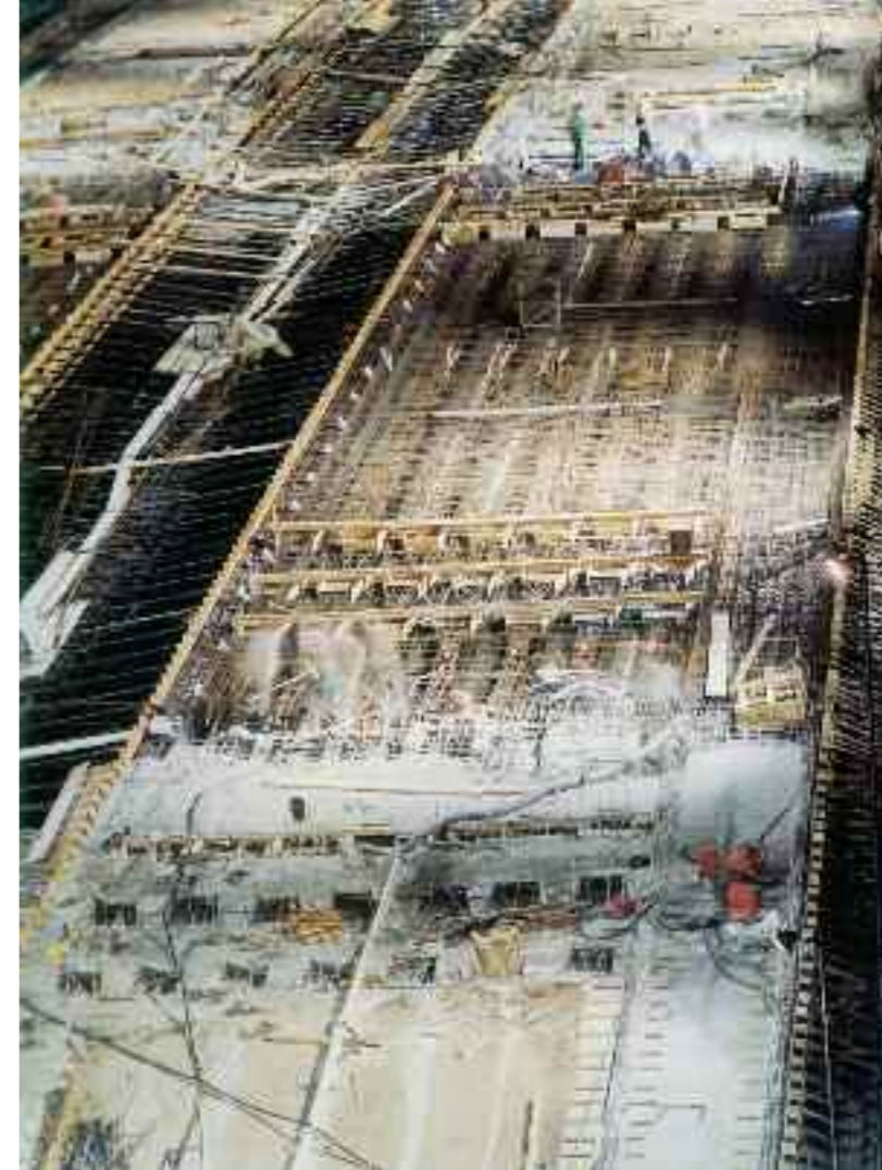
PONTE SUL TEVERE PER LA LINEA A DELLA METROPOLITANA A ROMA, S. ZORZI E L. MORETTI, IN COSTRUZIONE
