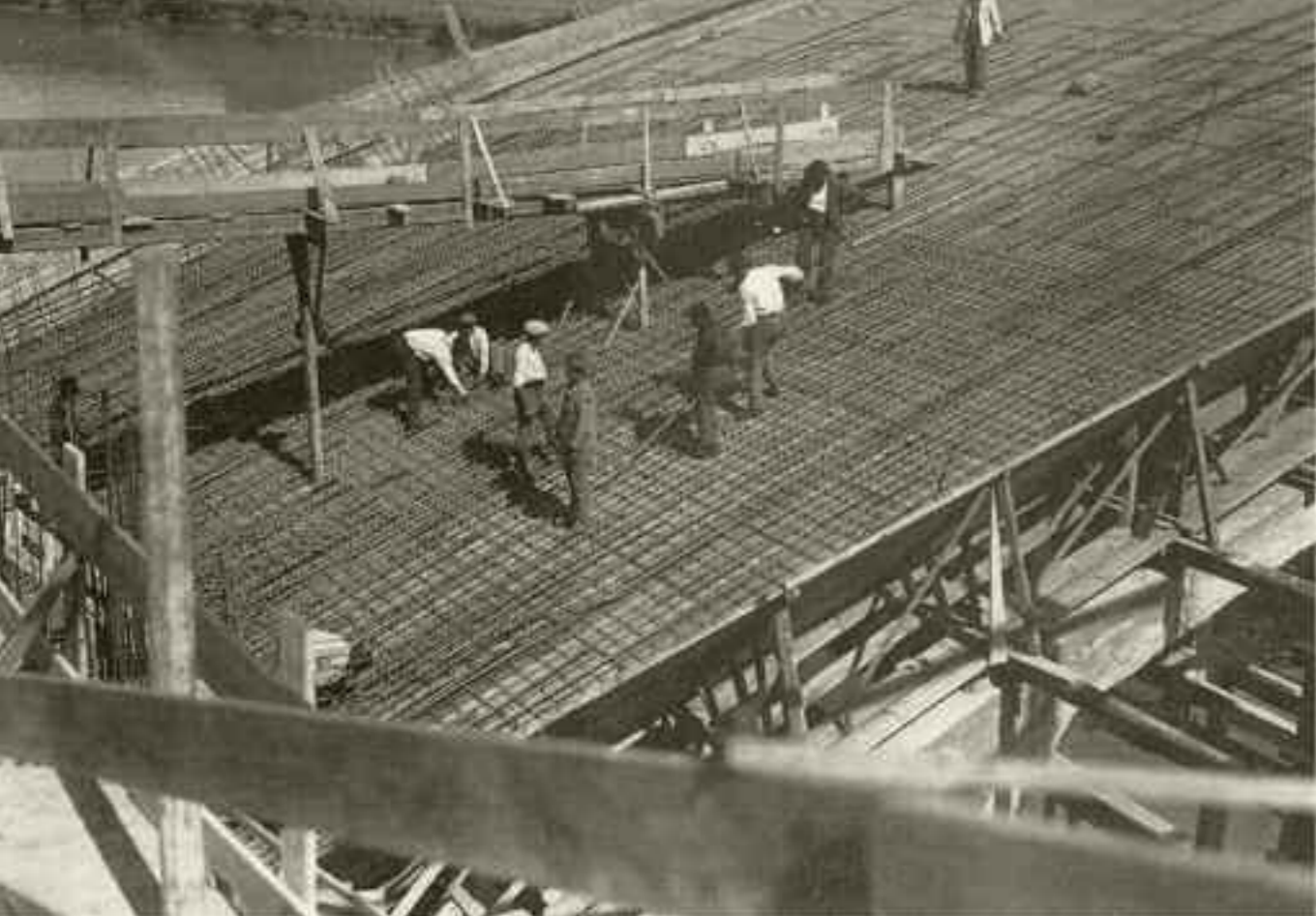
PONTE RISORGIMENTO A ROMA, IN COSTRUZIONE
