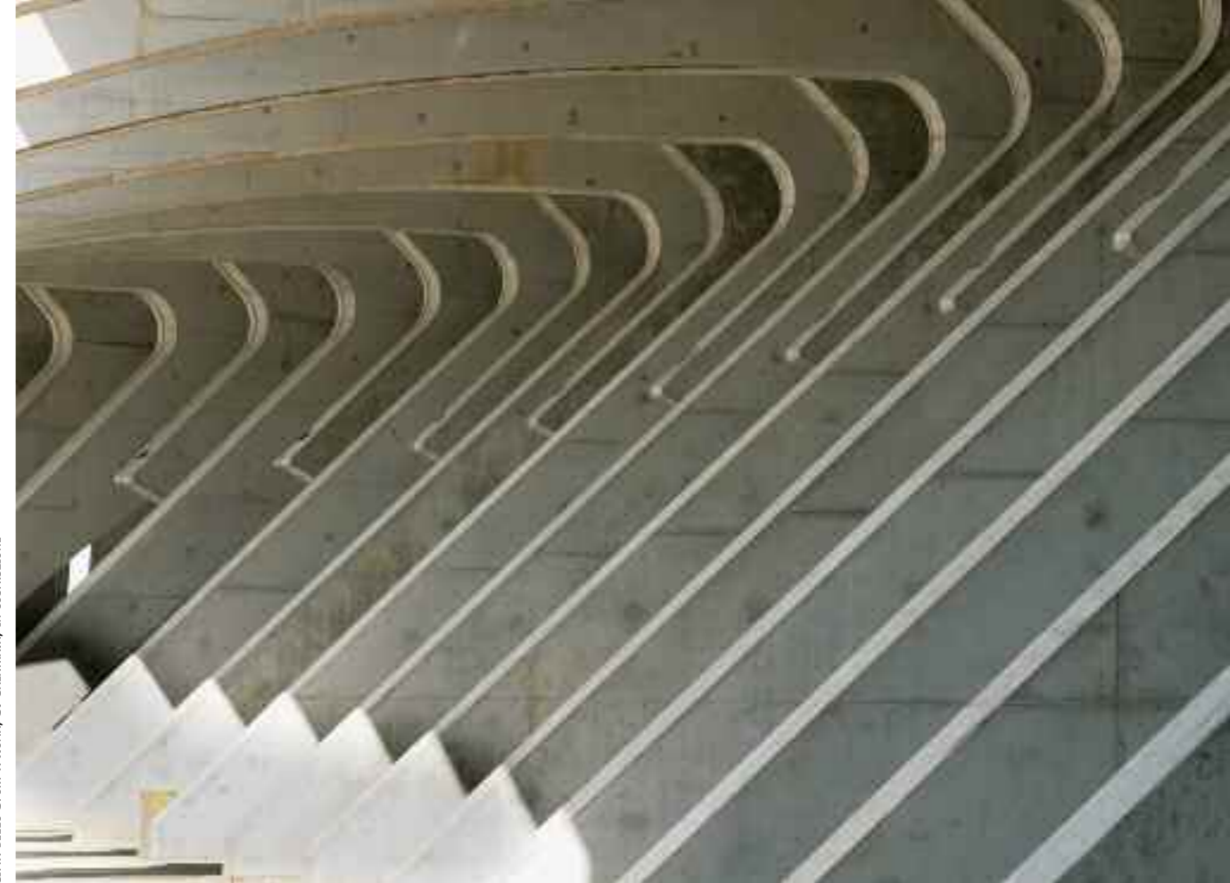
CITTÀ DELLO SPORT A ROMA, S. CALATRAVA, IN COSTRUZIONE
