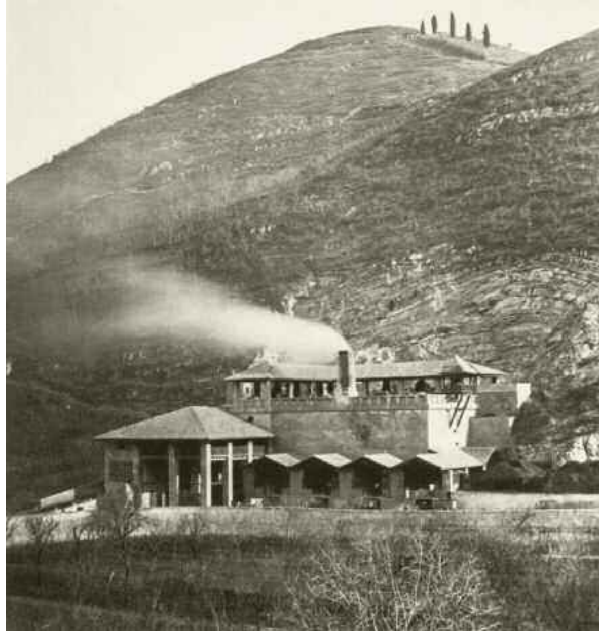
STABILIMENTO DELLA SOCIETÀ BERGAMASCA
