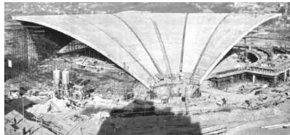
PALAVELA COM'ERA, F. LEVI, IN COSTRUZIONE
