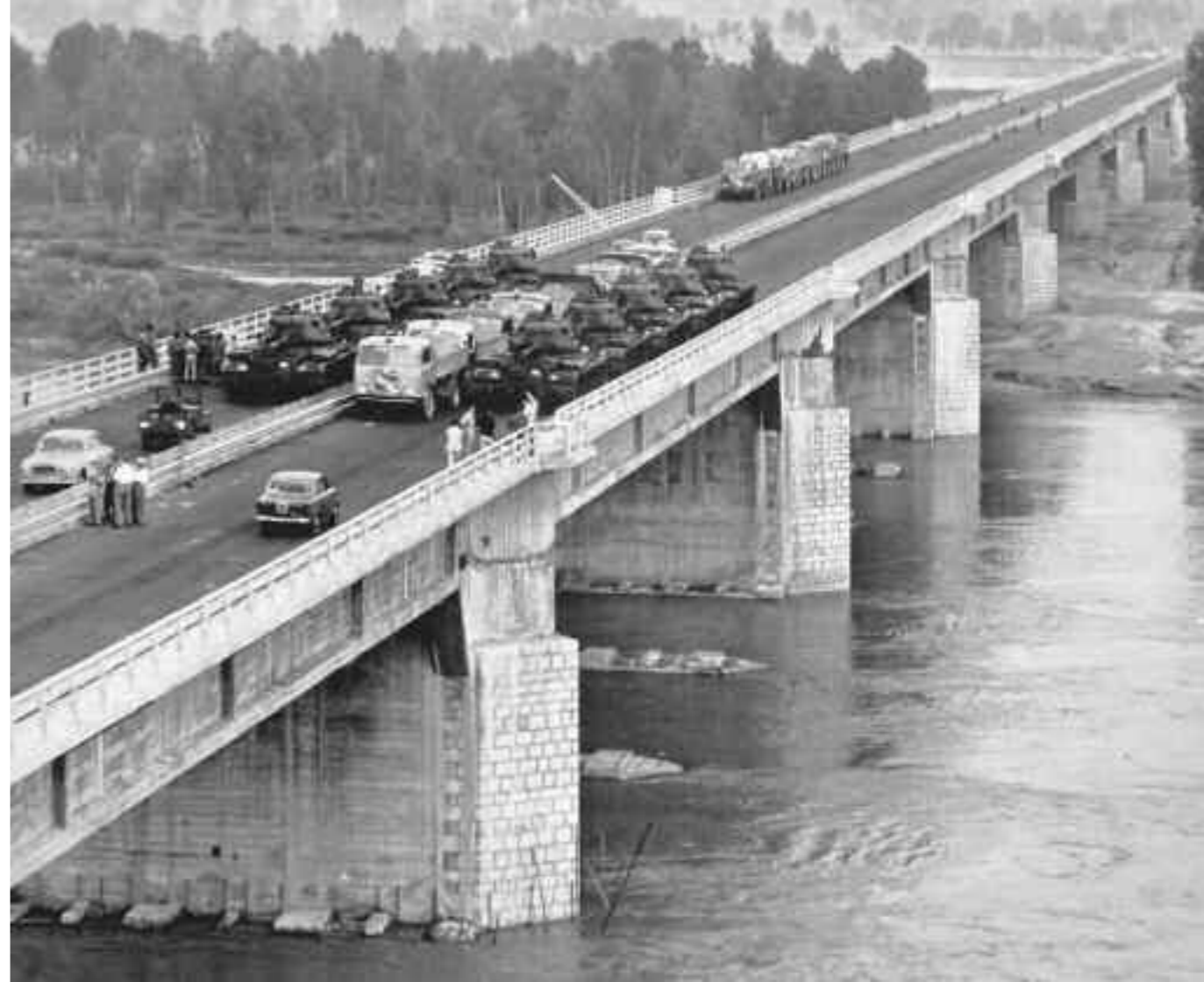
PONTE SUL PO PER L'AUTOSTRADA DEL SOLE, S. ZORZI
