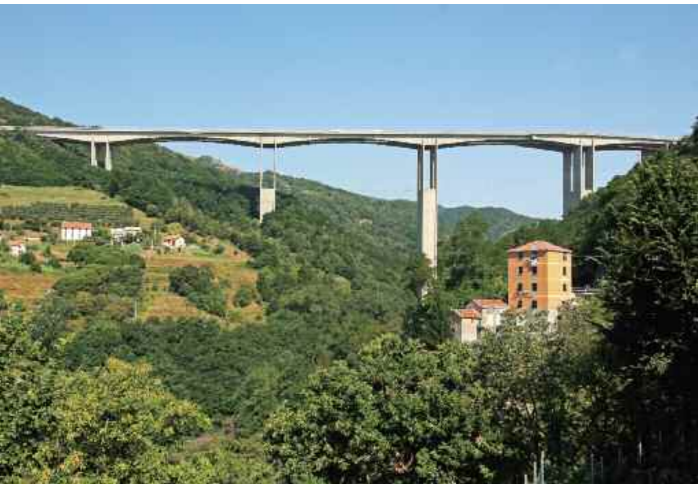
VIADOTTO SUL TORRENTE GORSEXIO SULL'AUTOSTRADA DEI TRAFORTI A VOLTRI, S. ZORZI
