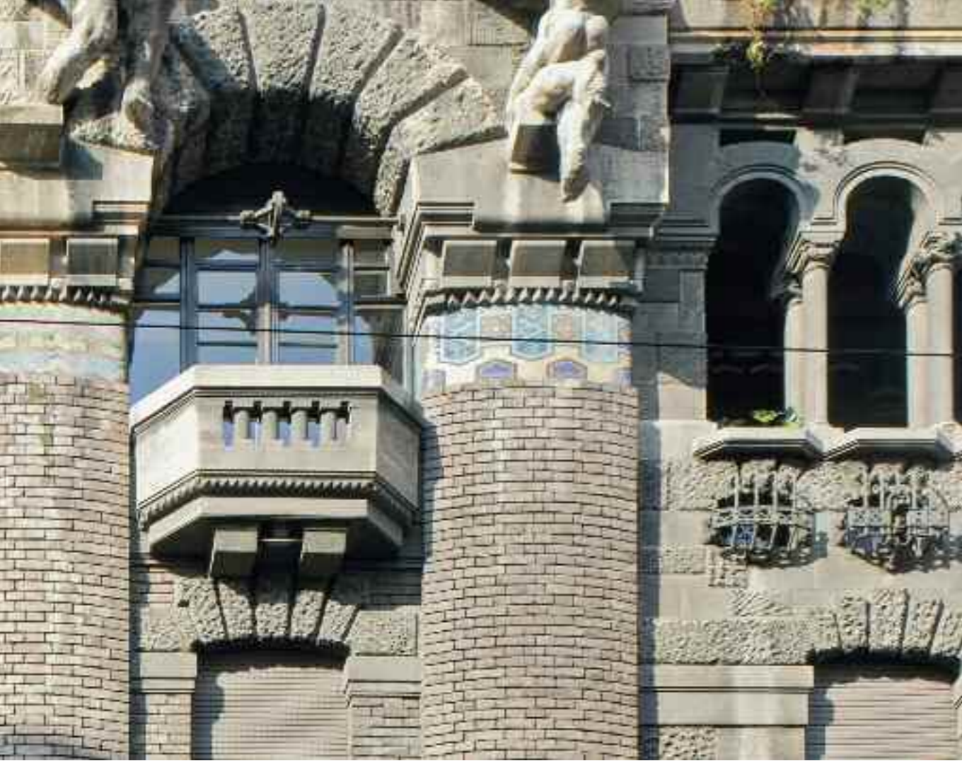
PALAZZO BERRI E MEREGALLI, MILANO, GIULIO U. ARATA, DECORAZIONI IN CEMENTO DITTA G. CHINI
