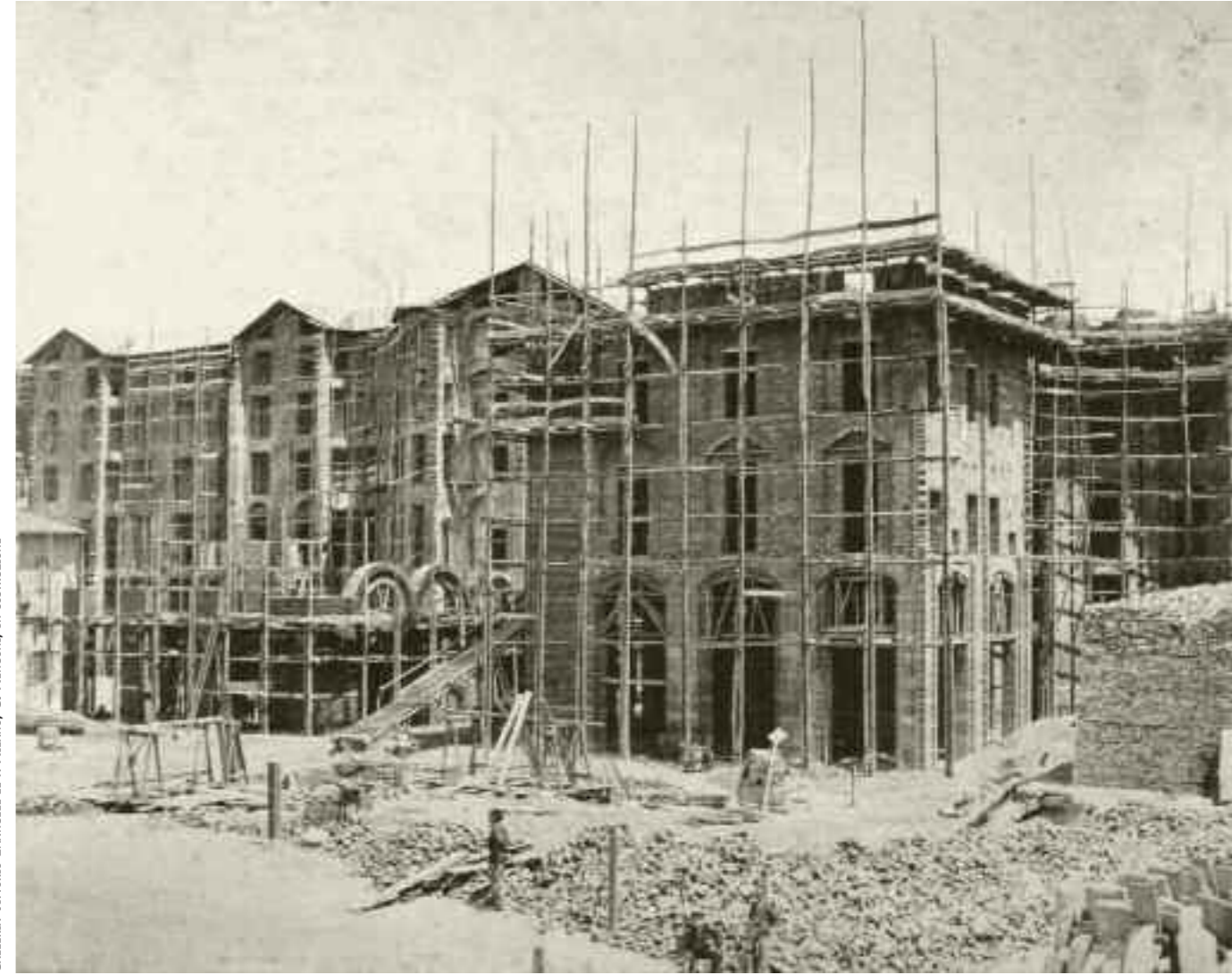
GALLERIA VITTORIO EMANUELE II A MILANO, G. MENGONI, IN COSTRUZIONE
