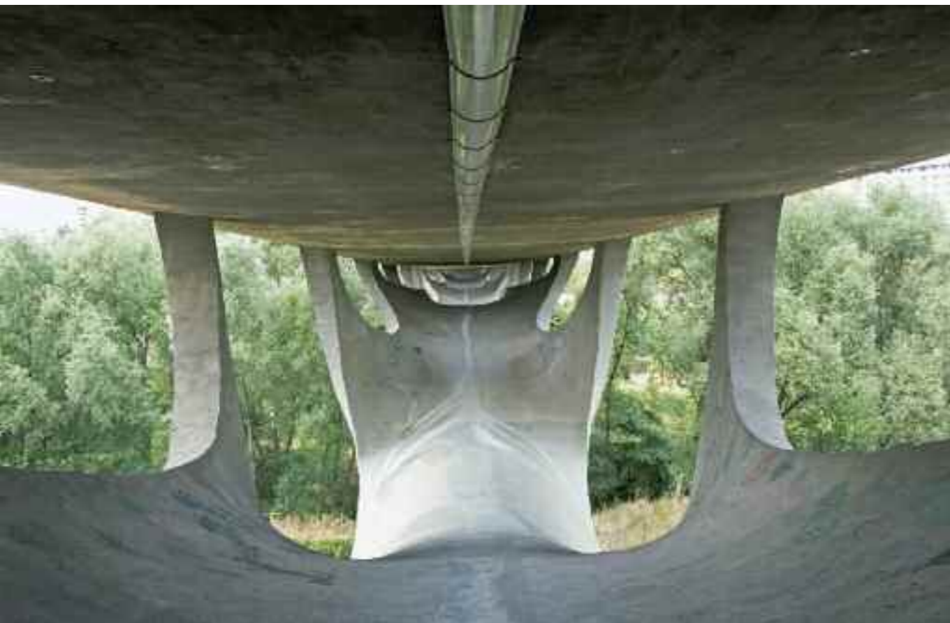
PONTE SUL BASENTO A POTENZA, S. MUSMECI
