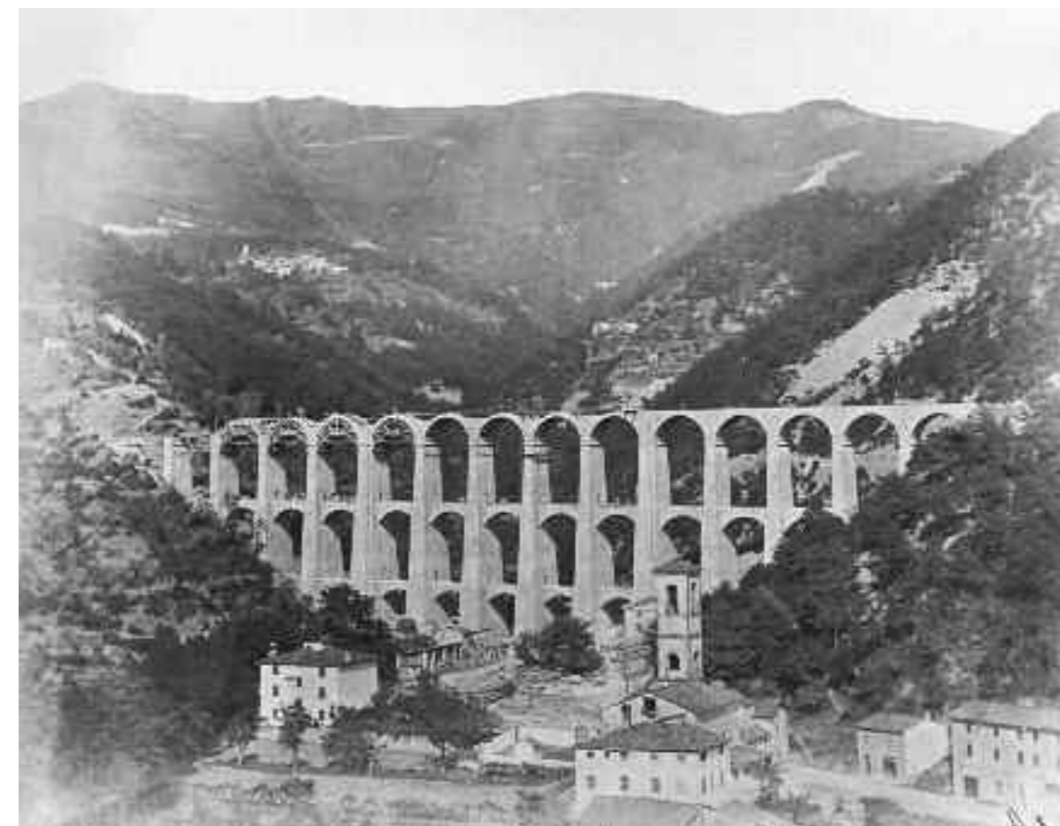
VIADOTTO PITECCIO SULLA LINEA CENTRALE, IN COSTRUZIONE
