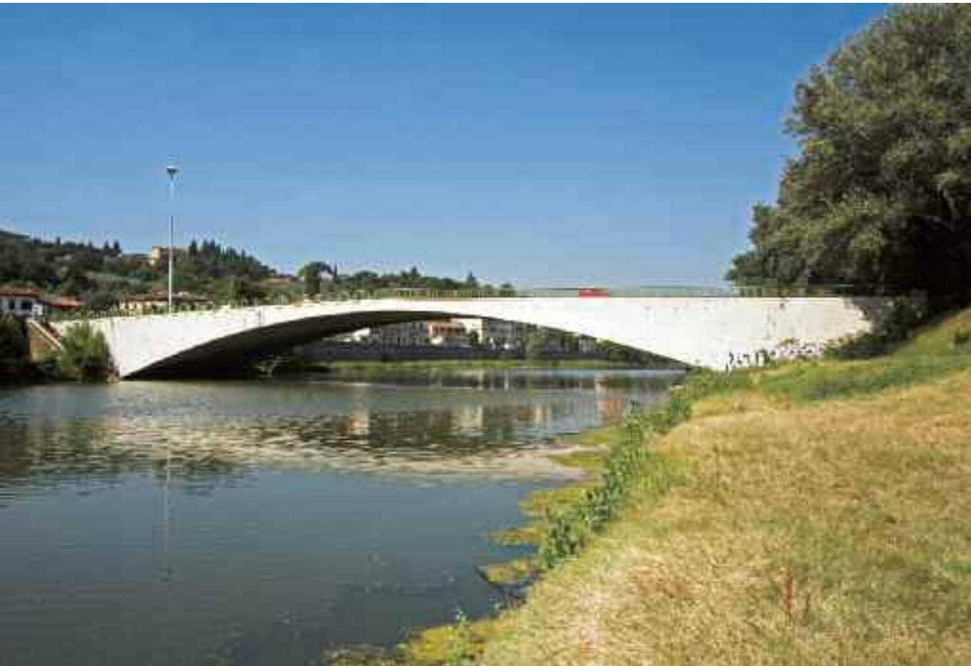
PONTE SAN NICCOLÒ SULL'ARNO A FIRENZE, R. MORANDI
