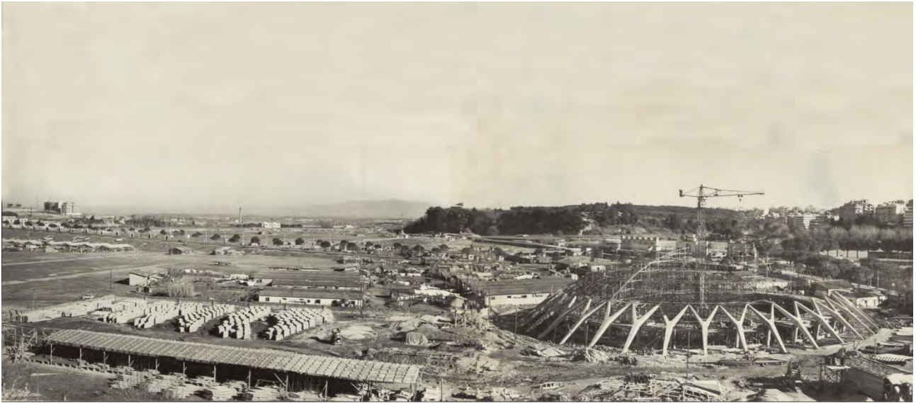
Fig. 17. The Palazzetto dello Sport full worksite: on the left, the prefabrication site; on the right, the cast-on-site and assembly site, 1956 (MAXXI Architettura, Centro Archivi, Roma: Fondo P.L. e A. Nervi).
