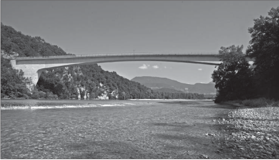
1. SILVANO ZORZI, PONTE SUL TAGLIAMENTO ALLO STRETTO TRA PINZANO E RADOGNA, 1967-1970. FOTO S. PORETTI.
