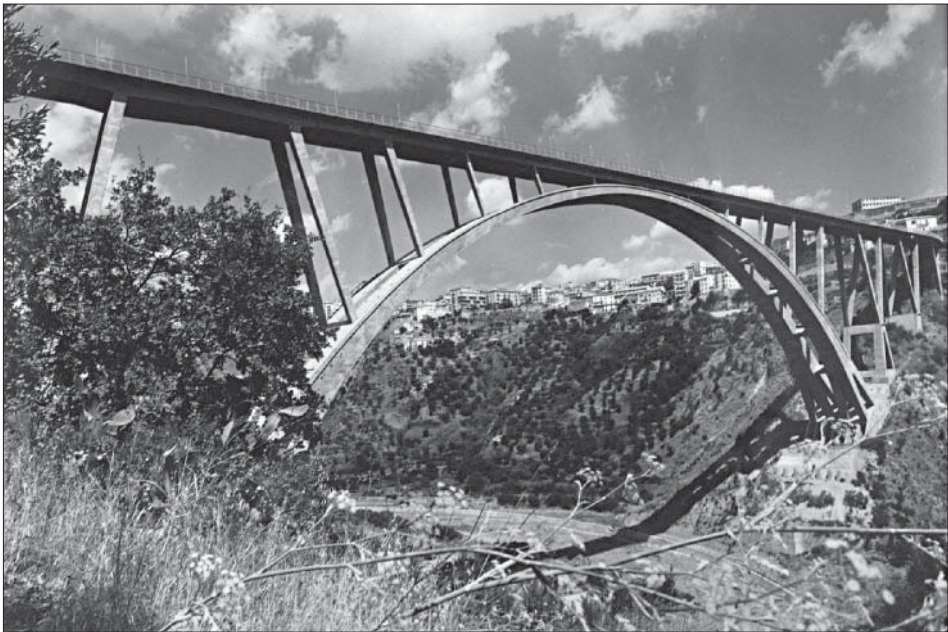
3. RICCARDO MORANDI, VIADOTTO SUL FIUMARELLA, CATANZARO, 1958-1964.
