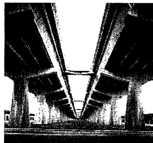
Viadotto Corso Francia L'infilata prospettica dei piloni a sagoma variabile realizzati dal 1958 al 1960
