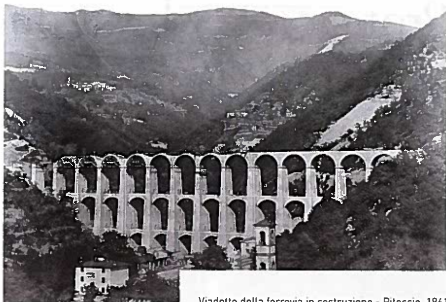
Viadotto della ferrovia in costruzione - Piteccio, 1861
